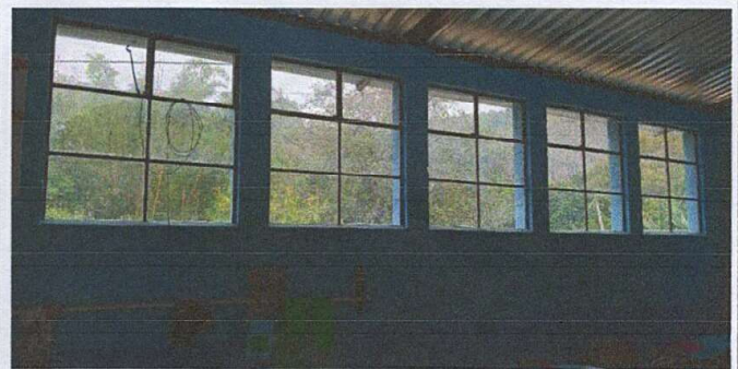
Foto 2: COLOCACIÓN DE PINTURA CORONA CLASICA COLOR BLANCO ANTIGUO Y ROJO TEJA, EN AULAS EXISTENTES.
